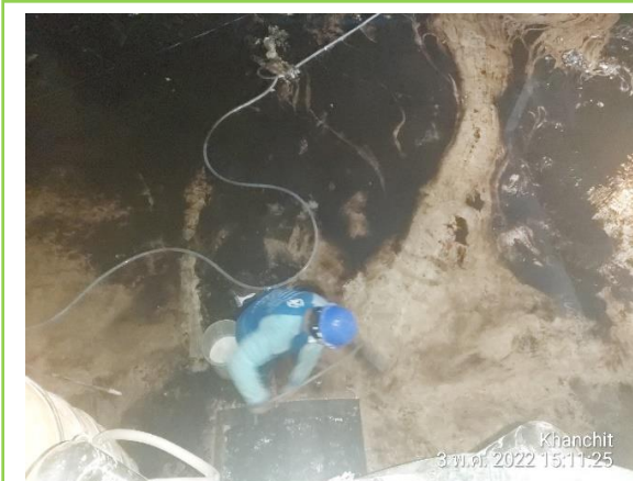
รูปที่ 3-23 การล้างทำความสะอาดถังสำรองน้ำใช้
