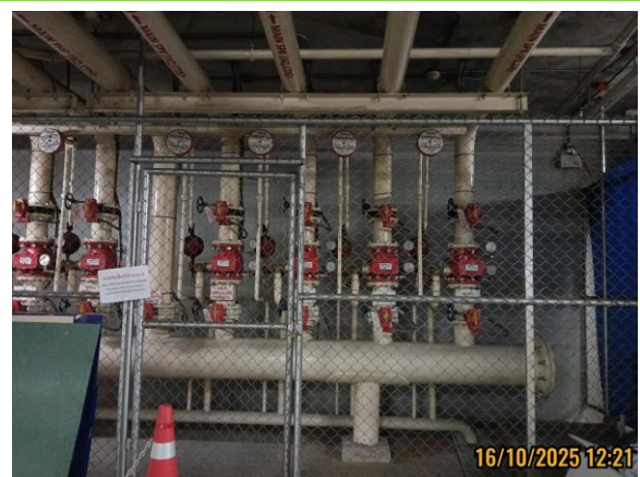
รูปที่ 3-56 ระบบท่อน้ำดับเพลิง
