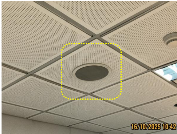
รูปที่ 3-51 ลำโพงแจ้งสัญญาณเตือนเพลิงไหม้
