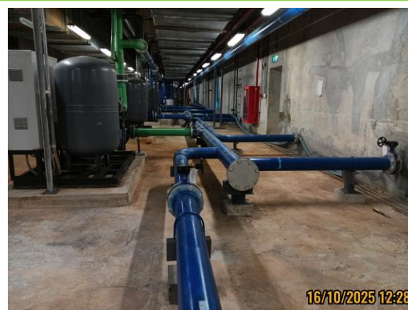
รูปที่ 3-21 ท่อรับน้ำประปา เข้าสู่บ่อเก็บน้ำคอนกรีต
