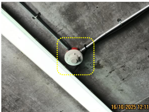
รูปที่ 3-53 อุปกรณ์ตรวจจับความร้อน
