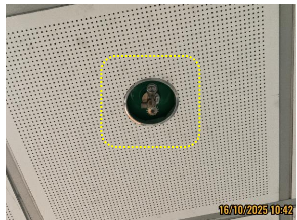
รูปที่ 3-54 ระบบหัวกระจายน้ำดับเพลิงอัตโนมัติ
