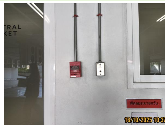
รูปที่ 3-49 อุปกรณ์แจ้งเหตุเพลิงไหม้แบบมือกด
